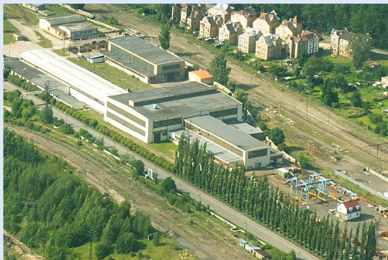
Svatavské strojírný s.r.o.
